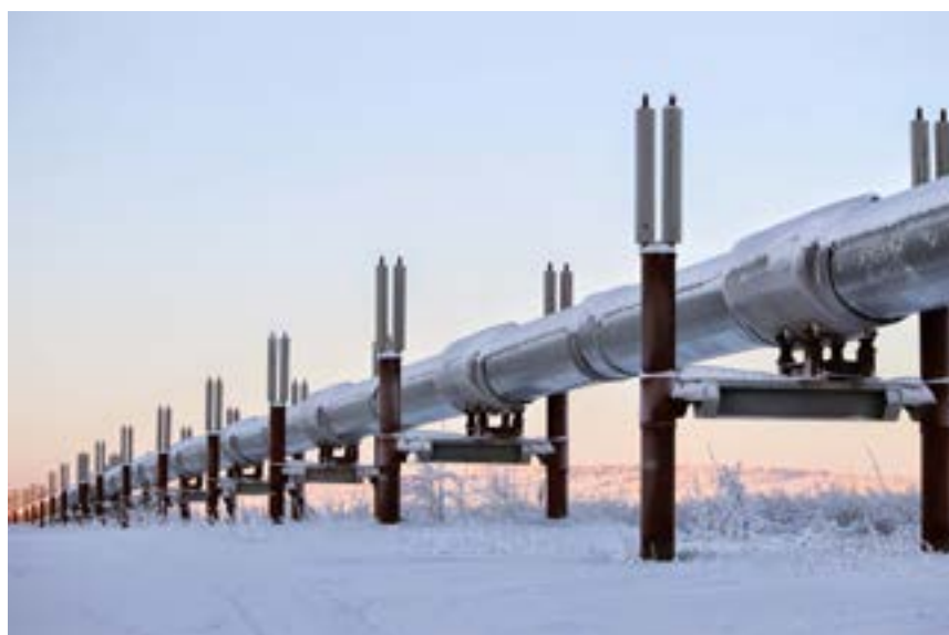
L'oléoduc trans-Alaska a été construit à la fin des années 1970. Long de plus de 1 000 km, il transporte le pétrole des champs pétrolifères du Nord jusqu'à la côte Sud, à Valdez, port libre de glace toute l'année.
